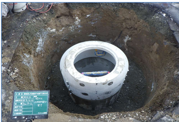
組立マンホール設置
