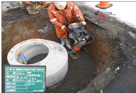
立坑埋戻し状況
