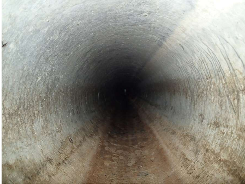
( 以前の下水道管内部 )
