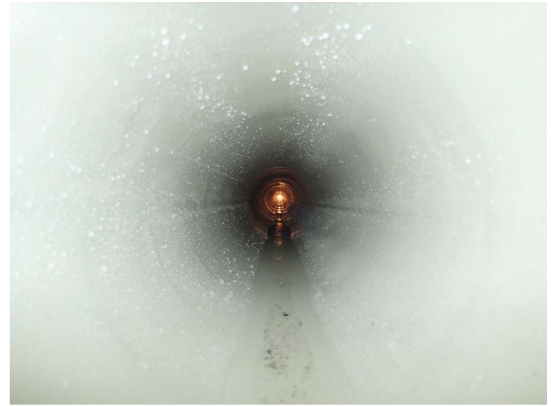
( 更新した下水道管内部 )
