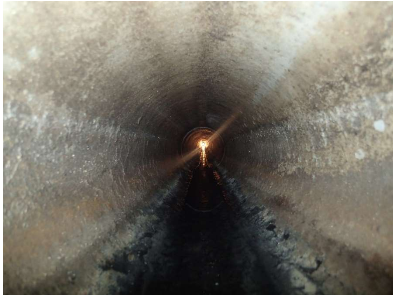
( 以前の下水道管内部 )
