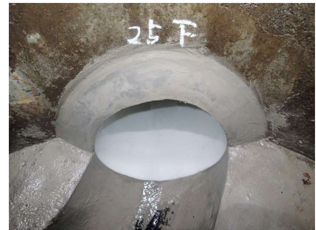
( 改修した下水道管口 )
